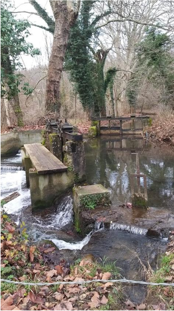
Les vannes au Rivier
