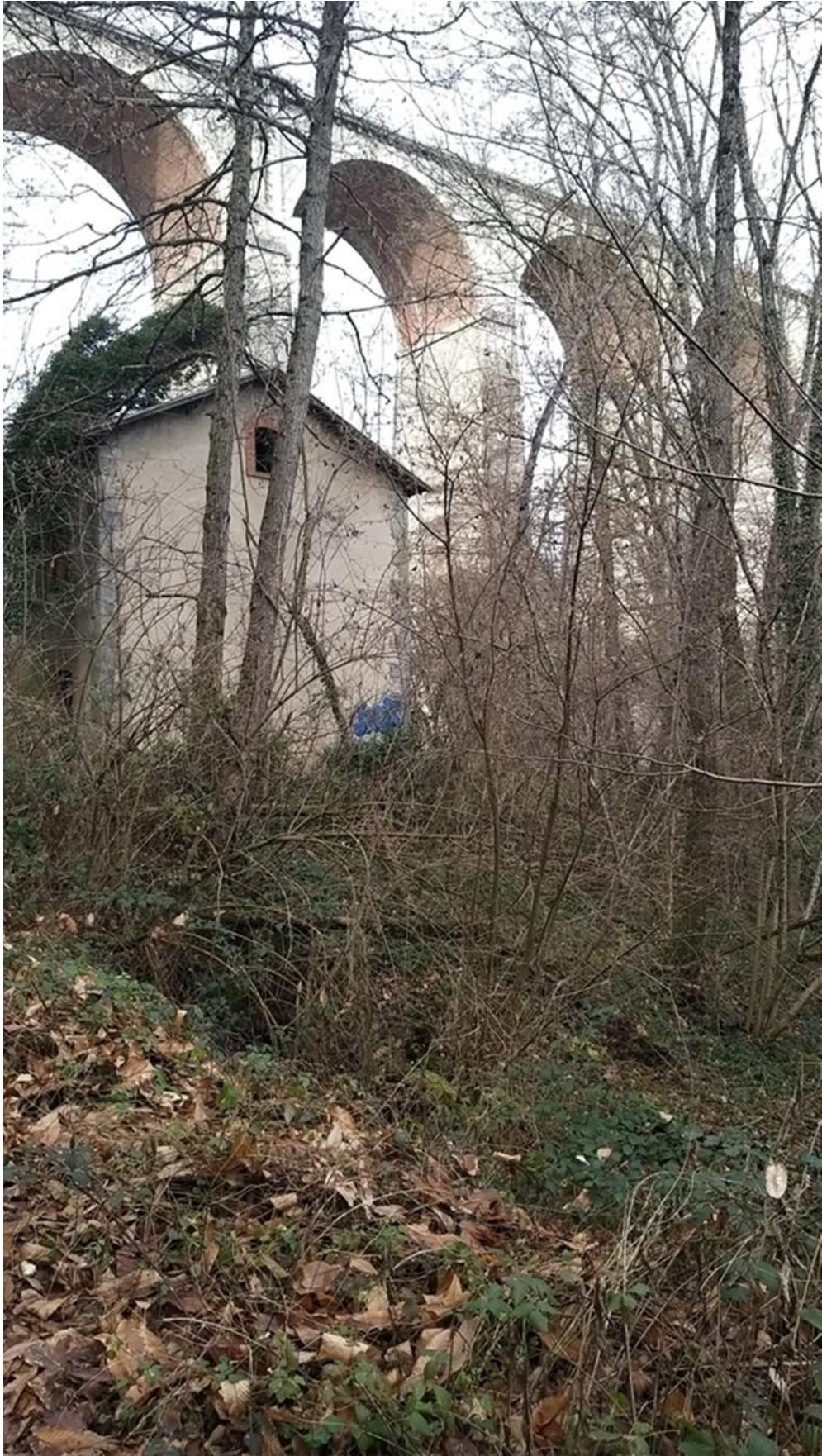
La station de pompage sous le Pont du Bœuf
