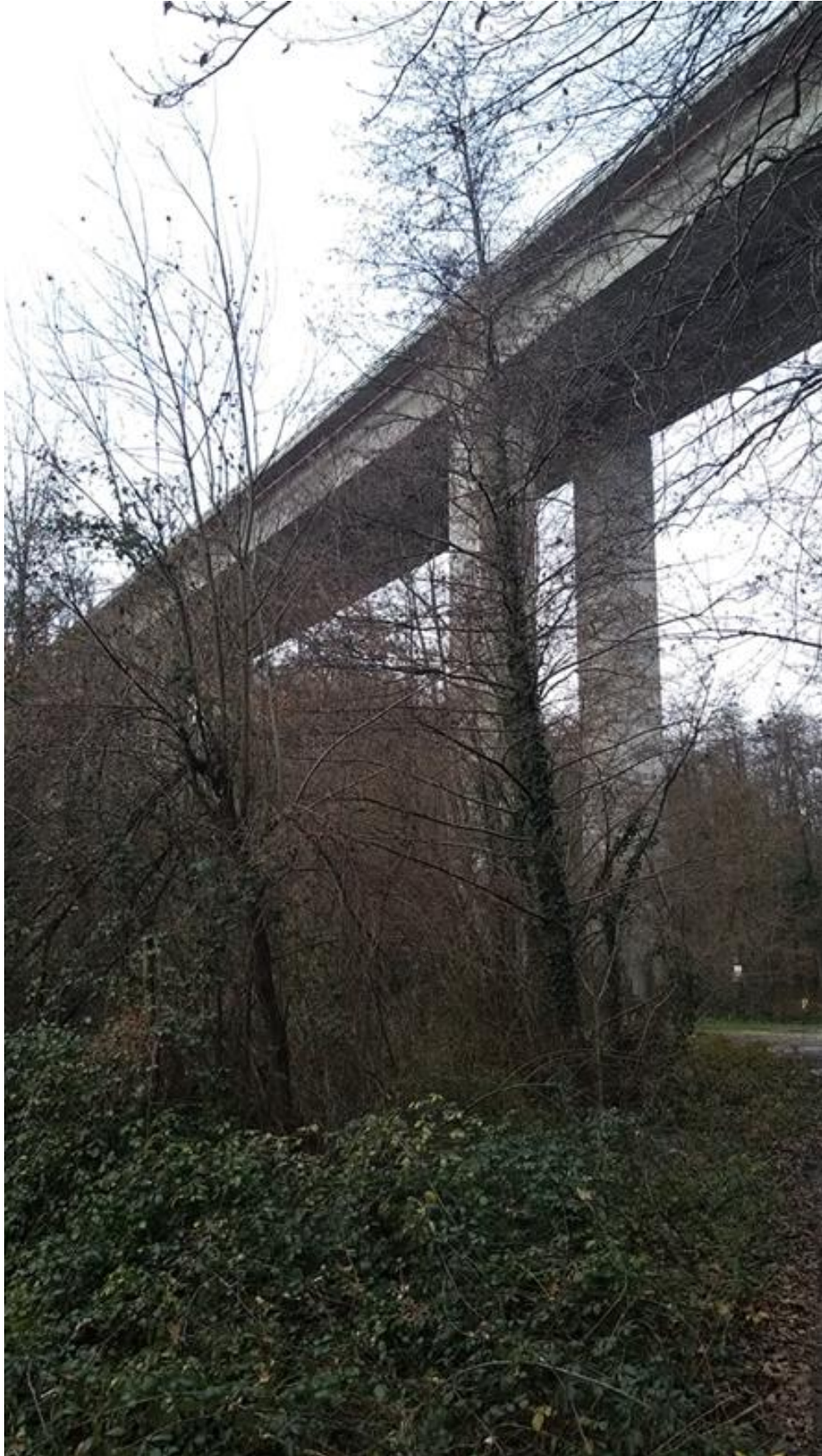
Pile centrale du pont de l'autoroute
