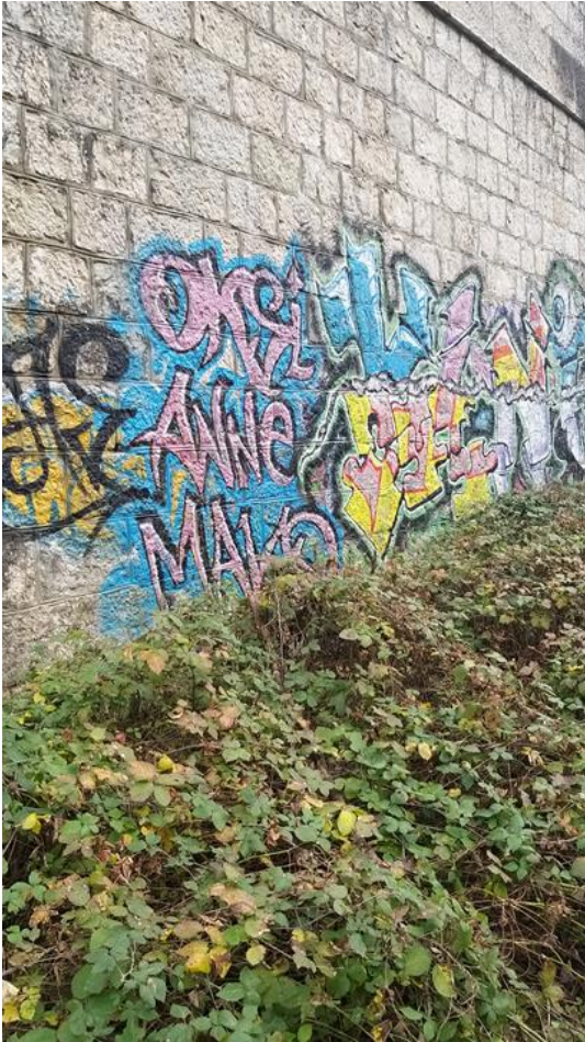
Une arche taguée du Pont du Bœuf
