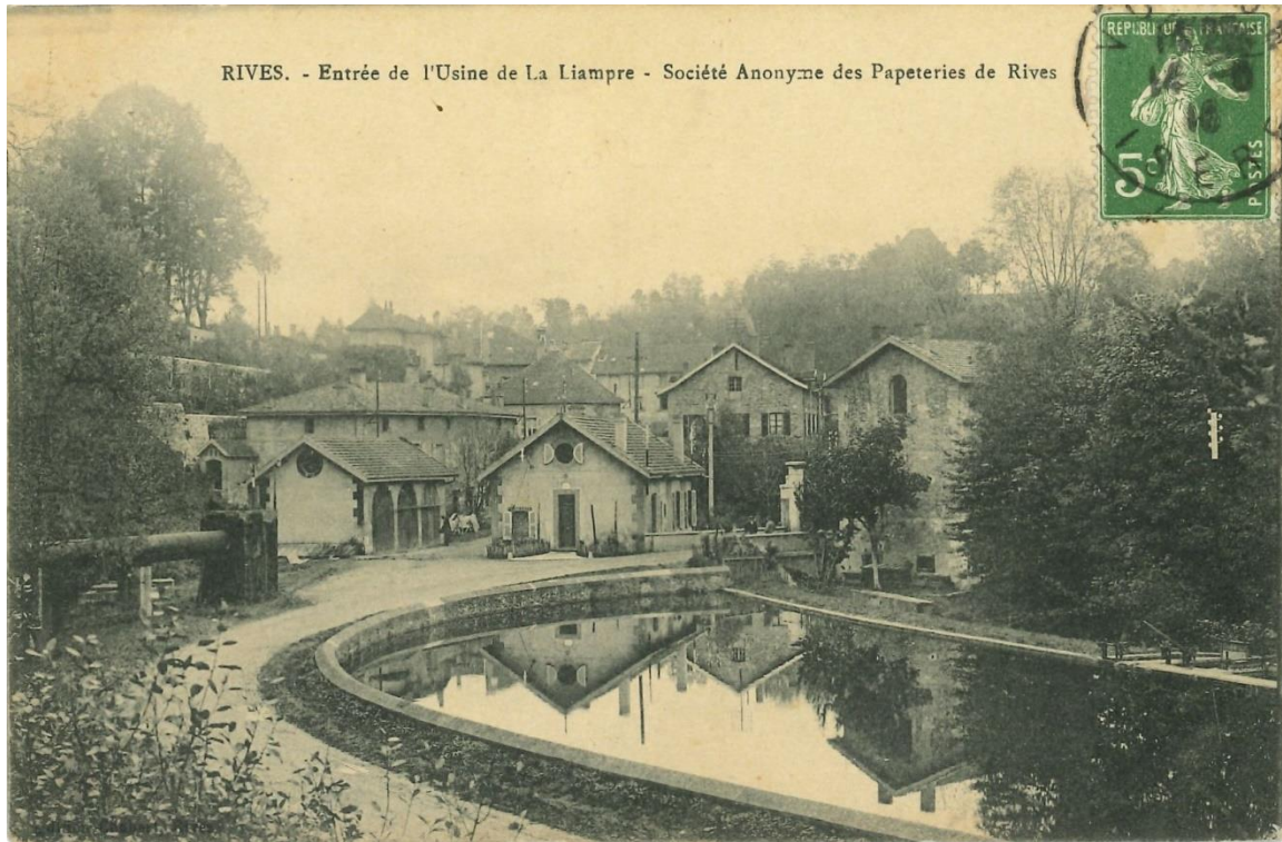
Entrée usine de la Liambre
