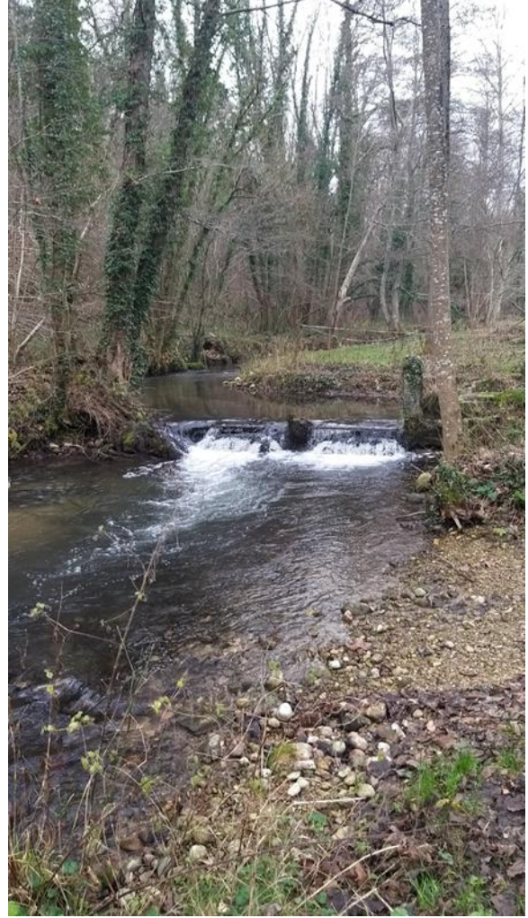
Reste des vannes en amont du pont de l'autoroute
