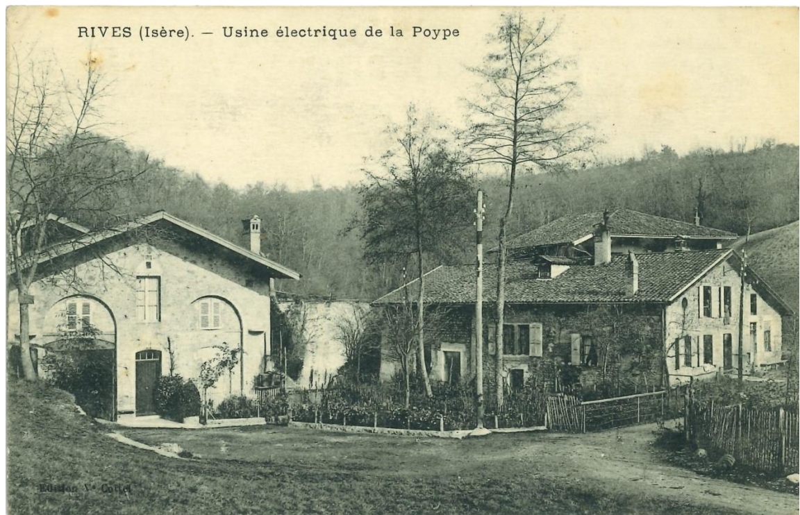
Usine électrique de la Poype
