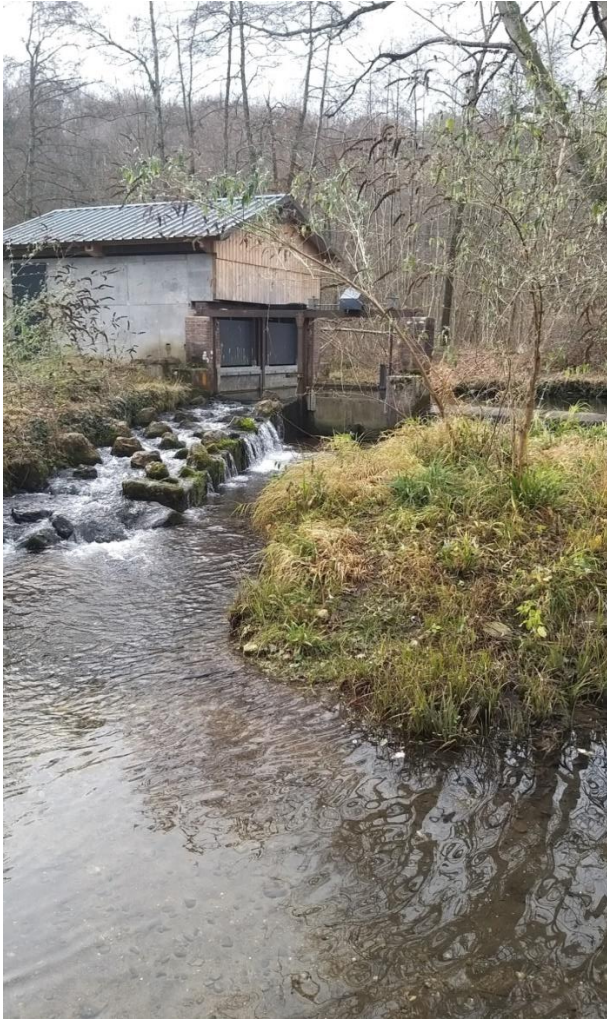
Les vannes de notre enfance avec le nouveau bâtiment. Départ du canal de la cressonnière
