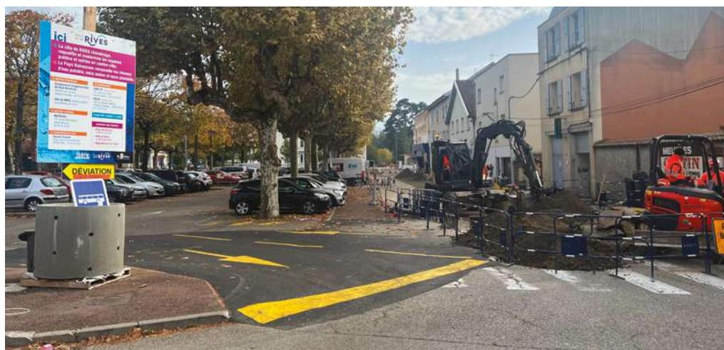
Comme programmés initialement, les travaux de requalification du centre-ville entrent dans une nouvelle phase. Initiés rue Georges Janin-Coste, ceux-ci consistent en une reprise des réseaux d'adduction d'eau potable et des réseaux d'assainissement (eaux usées et mise en séparatif eaux pluviales), directement suivie par le reprofilage des voiries avec création de cheminements piétons sécurisés aux normes et reprise des revêtements de voi-
